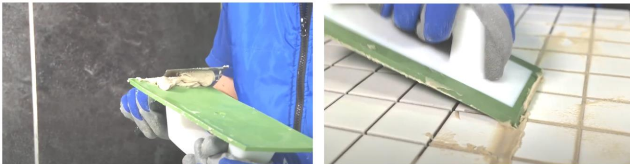
Рис. 5. Заполнение швов цементной затиркой при помощи резинового шпателя
